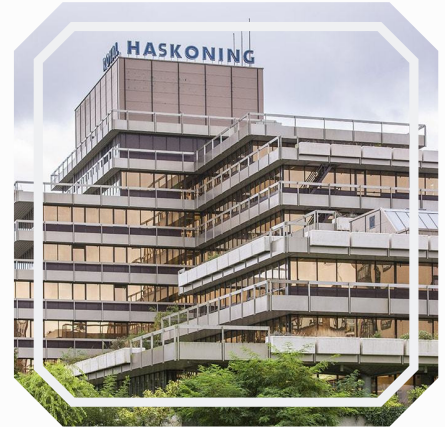
Krystaline Repair System- Parking Estel Residence - Nimega (Países Bajos)
