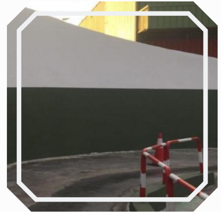
Krystaline Repair System- Muro de contención - Tenerife (España)
